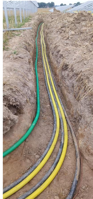
Figur 5. Exempel på kabelschakt från Bolagets anläggning i Forsby.
