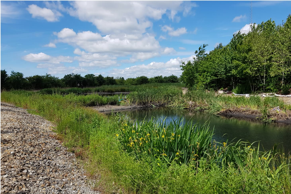
Figur 13. Foto av sedimentationsdamm 1 (närmast i bild), makadamvallen som separerar dammarna samt sedimentationsdamm 2 (skymtas längst bort i bilden). Foto taget av Sweco i juni 2022.
