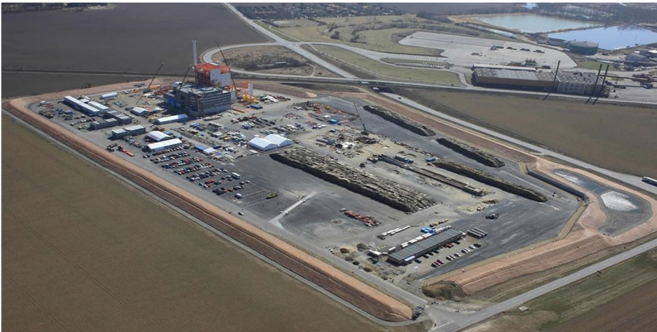
Figur 2. Foto av Örtoftaverket från 2013 som visar vallen som är anlagd runt området. Fotot är tillhandahållet av Krafringen AB.
