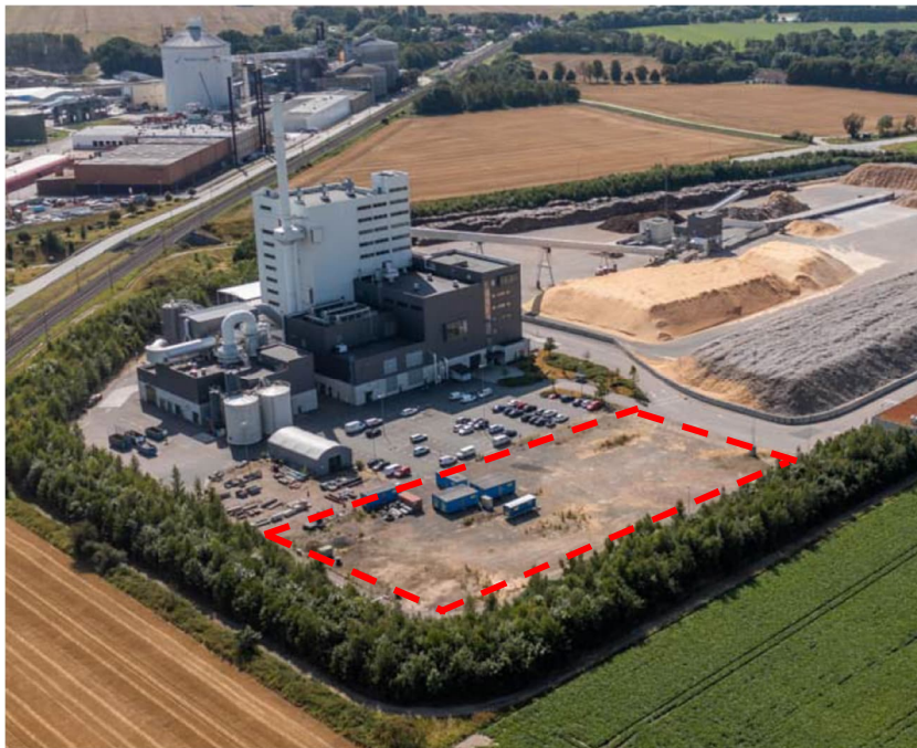
Figur 4. Bild av Örtoftaverket med ytan avsedd för utökad verksamhet markerad med röd streckade linjer.
