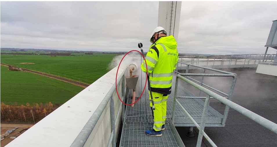
FIGUR 6: AVGASNING TILL MATARVATTENTANK PÅ PANNBYGGNADENS TAK, VY MOT ÖSTER.
