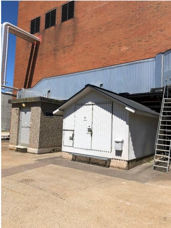
Figur 3. Oljecisternen för E01 förvaras i den vita containerbyggnaden till höger.
