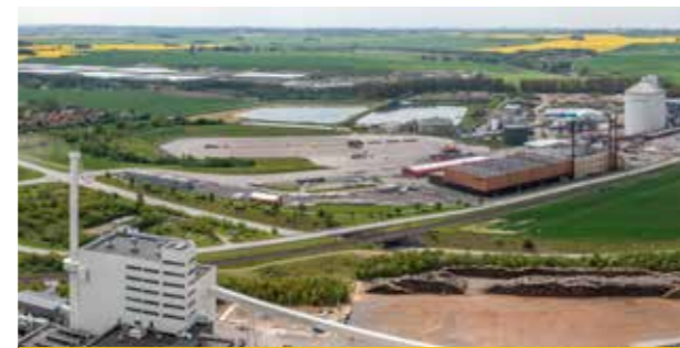
Mellan Örtoftaverket och Nordic Sugars sockerbruk i Eslöv bygger vi en 1,1 km lång ledning för att kunna leverera fossilbränslefria ånga, vilket kommer minska brukets utsläpp med 17 000 ton CO2e/år.
