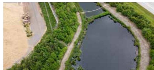
Intill Örtoftaverkets bränslegård finns ett anlagt dammsystem som renar vatten från vår verksamhet innan det rinner ut till Kävlingeån.
